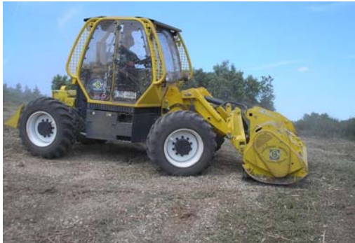
Engin de débroussailllement et le résultat de son travail: un sol "propre" et partiellement décapé (photo Baudel J.)
