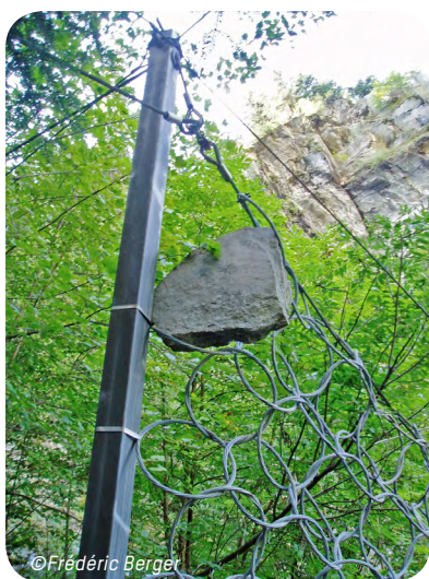
Filet pare-pierres pour la protection contre les chutes de blocs
