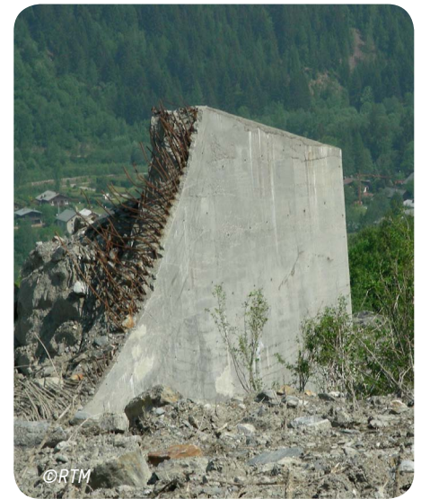
2002, Tacconnaz, obstacle paravalanche en béton armé partiellement détruit par l'avalanche de 1995
